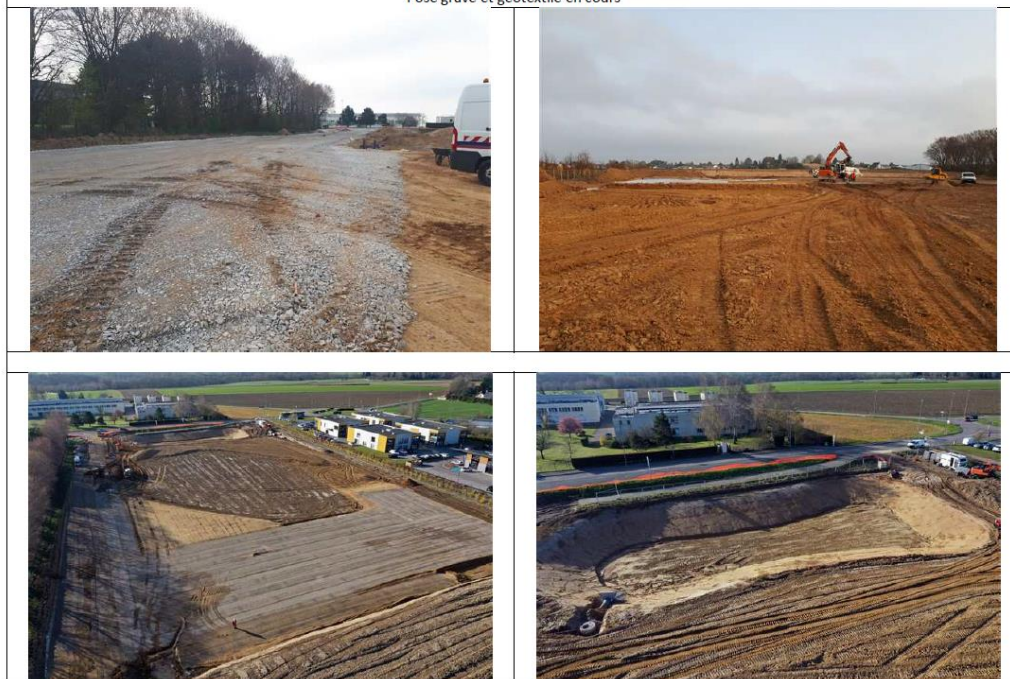
Pose grave et géotextile en cours
